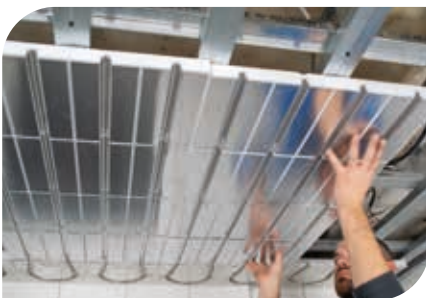
Anbringung auf abgehangene Trockenbau Unterkonstruktion.
