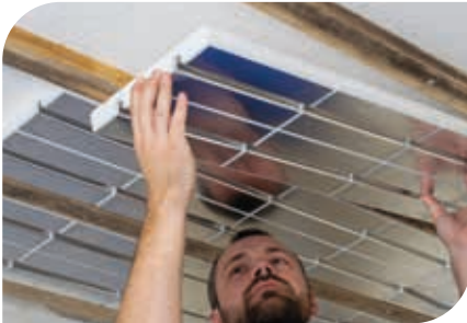
Einfache Installation mittels Zwischenlattung im Trockenbau-System.
