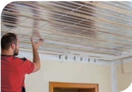
Optimale Verlegung durch Rohrführungen der Heizelemente.
